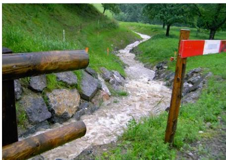
Figure 6 : Freiebach de Hombourg dans le jardin fruitier, renaturation du ruisseau / protection contre les crues (mise sous terre vs. ouverture). © Peter Werner / Holenstein Ingenieure SA
